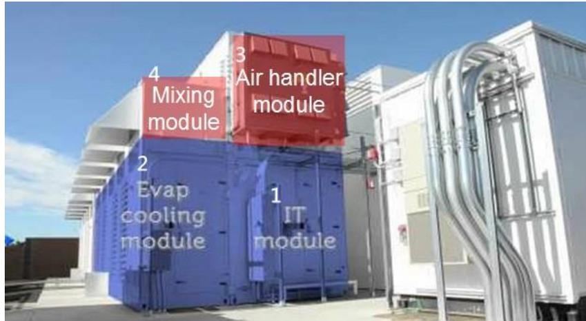
圖 9 DELL 數據中心的構成模組<sup>[9]</sup>
