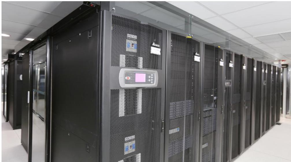
圖 5：熱通道封閉技術實例
