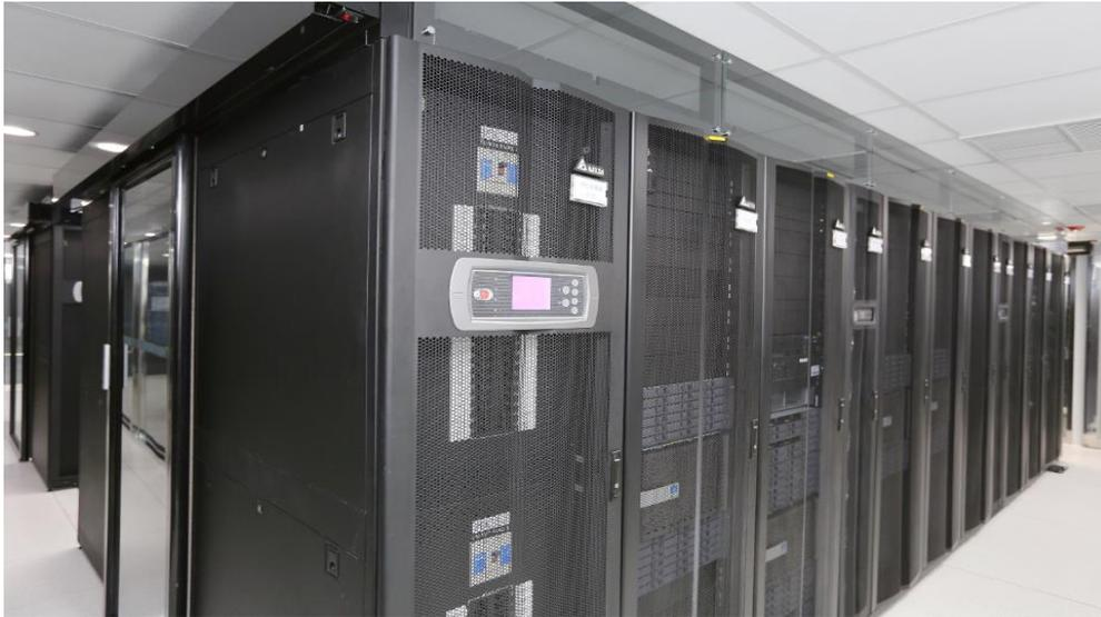
Figura 6. Exemplo de contenção do corredor quente
