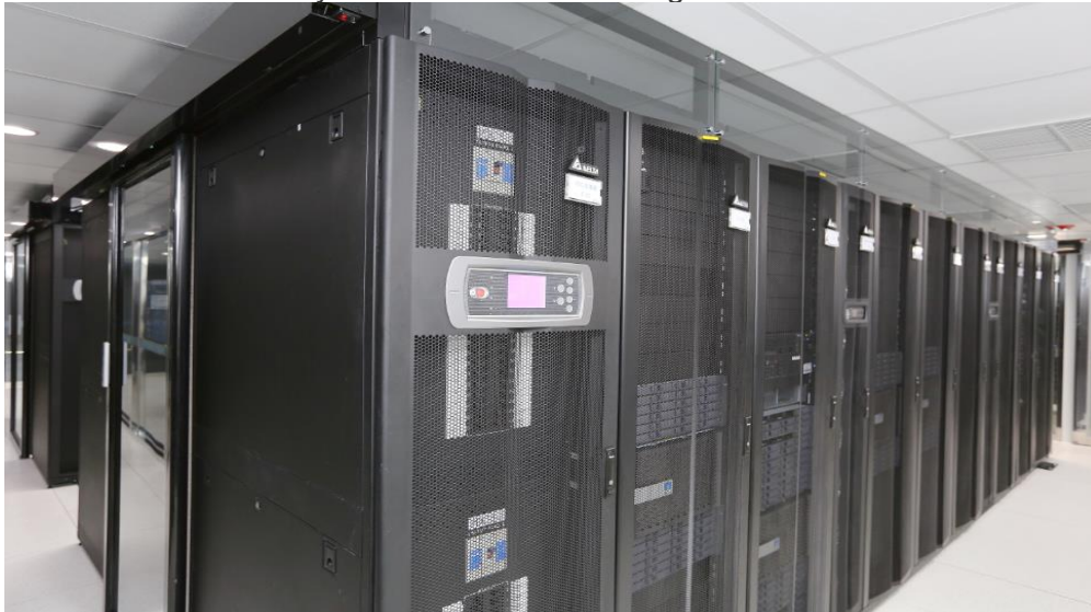
Figura 6. Ejemplo de contención de pasillo caliente
