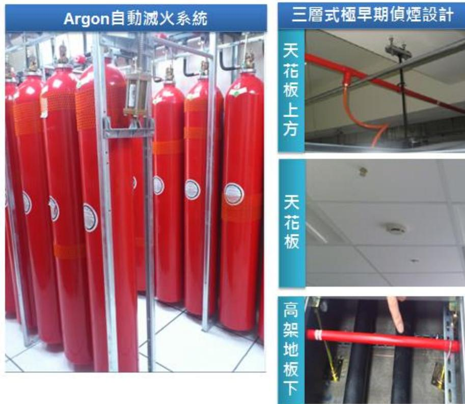
圖11 氬氣消防滅火系統(左)，極早期偵煙(右)
