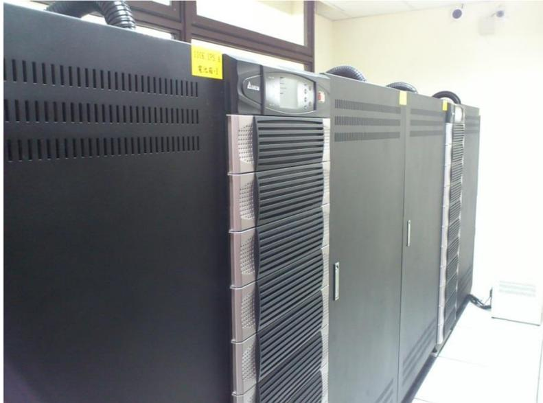
圖5 模組化不斷電系統，具有高彈性隨需擴容的能力
