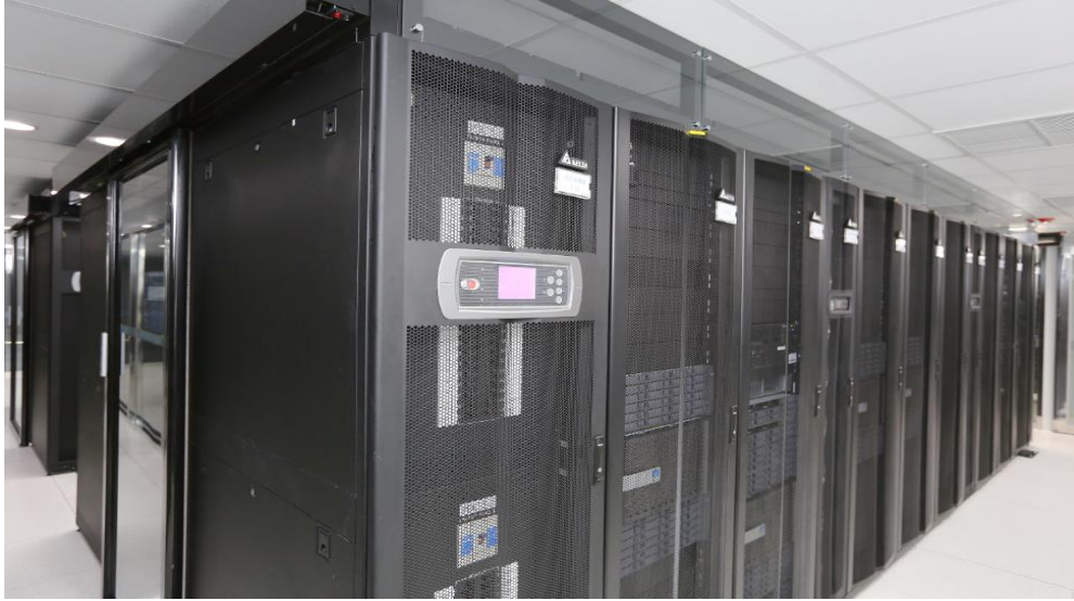
Figure 6 : Exemple de confinement d'allées chaudes
