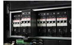
Opcional PDC para montaje tipo rack, con módulo de control y módulos de interruptores intercambiables en caliente.
