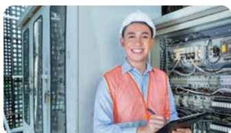
ORT (test de fiabilité en cours)
